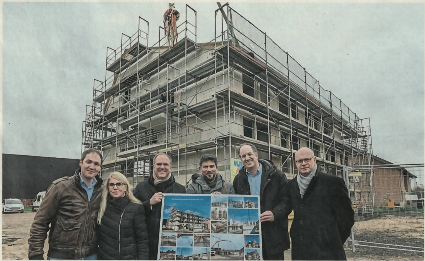
Eine Bildcollage zeigt die Baufortschritte für die Wohneinrichtung an der Ursulastraße.
