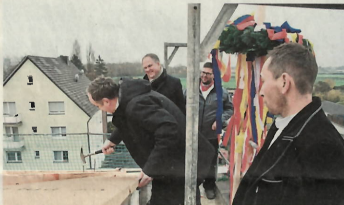
Die letzten Nägel schlugen GWG-Geschäftsführer Klaus Pelzer (l.) und Bürgermeister Dirk Breuer ins Dachgebälk.
