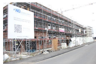
Hürth-Efferen, Nettgesweg (6-zügige Kita und 15 Wohneinheiten)
