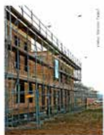
Im großen Saalraum sind nun die Baustellen für die Kindertagesstätte entstanden.
